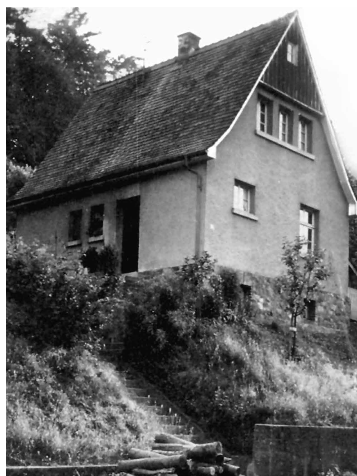
Arbeiterhaus, Wacker&Doerr, Karlstraße 55, Foto 1943
