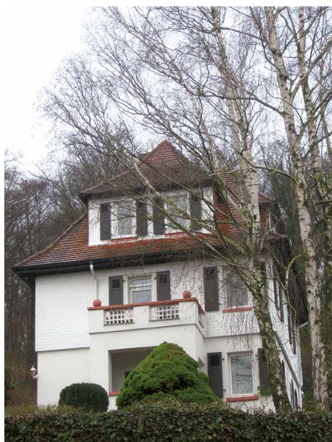
Villa Berg, Treppenstraße 8, Foto 2013
