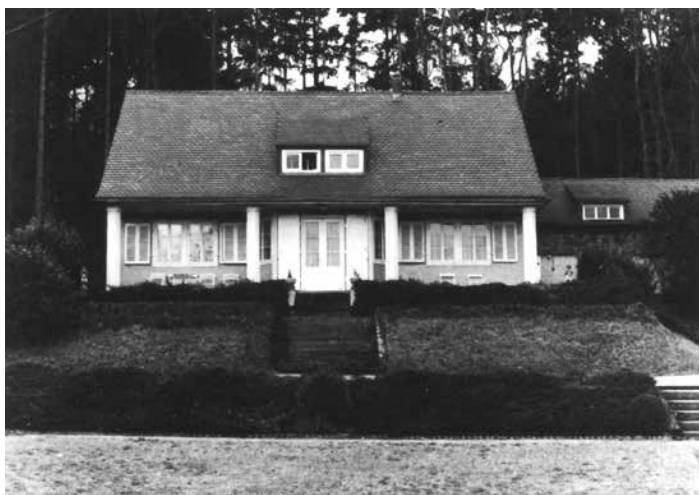
Haus Velte, Lindenbergweg, erbaut 1920/21; Architekt Prof. Hch. Walbe, Darmstadt
