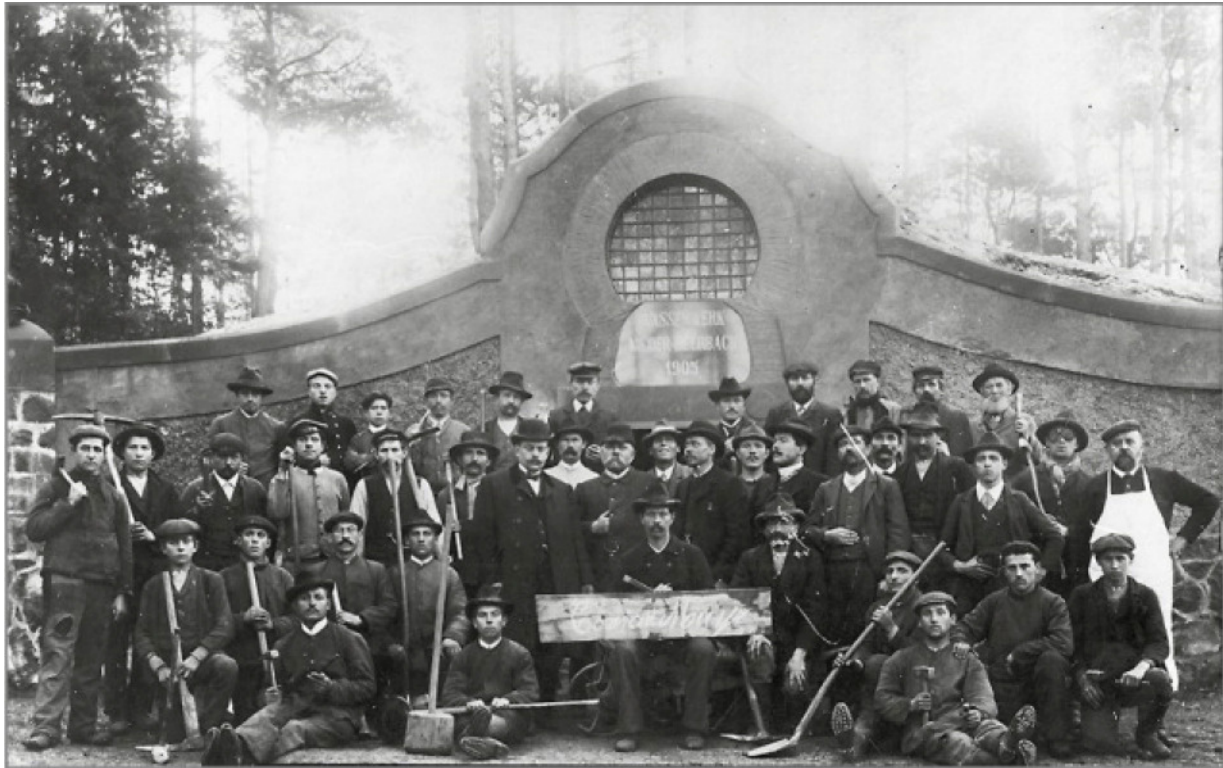
Wasser marsch: Gruppenbild mit Standespersonen und Bauarbeitern zur Einweihung des ersten Wasserwerks in Nieder-Beerbach im Jahre 1905. Foto: Archiv Arbeitskreis Heimatgeschichte Mühlthal.
